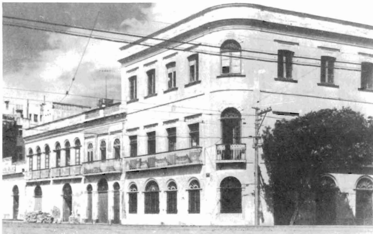
Antigo prédio da Secretaria da Fazenda e casas vizinhas da Avenida Martins de Barros que foram demolidos para a construção do novo prédio da Secretaria
